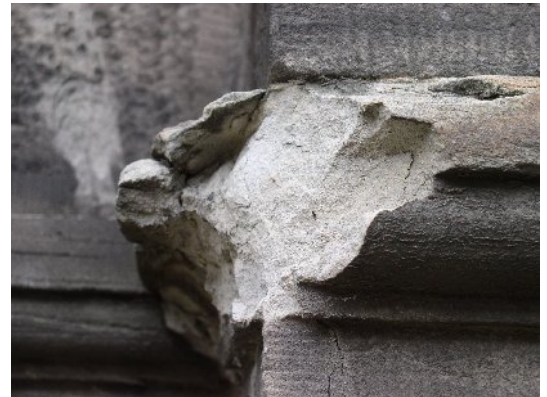
Ausbruch in Folge von Bröckelrissbildung (Ohne Maßstab)
