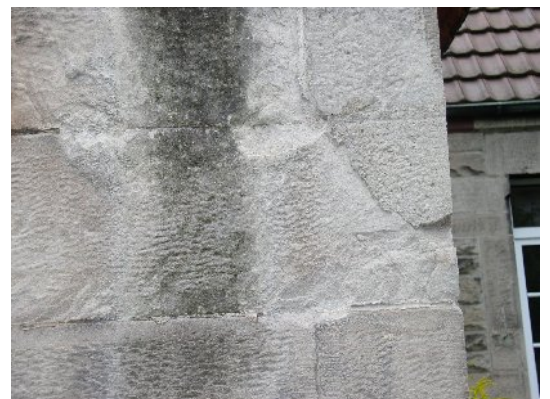
Oben rechts Antragung mit angrenzender Rückwitterung. (Ohne Maßstab)
