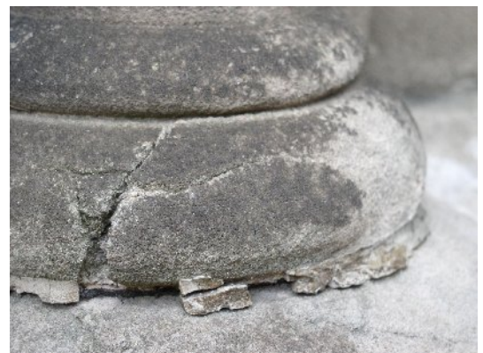
Fein bearbeitete, wahrscheinlich abgeriebene Profiloberfläche
