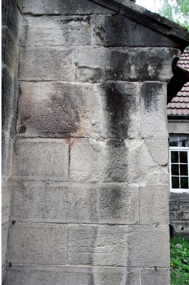
Abbildung 1: Mauerquader Positionen 01.02.3ff, 02.02.1ff und 03.02.1ff
